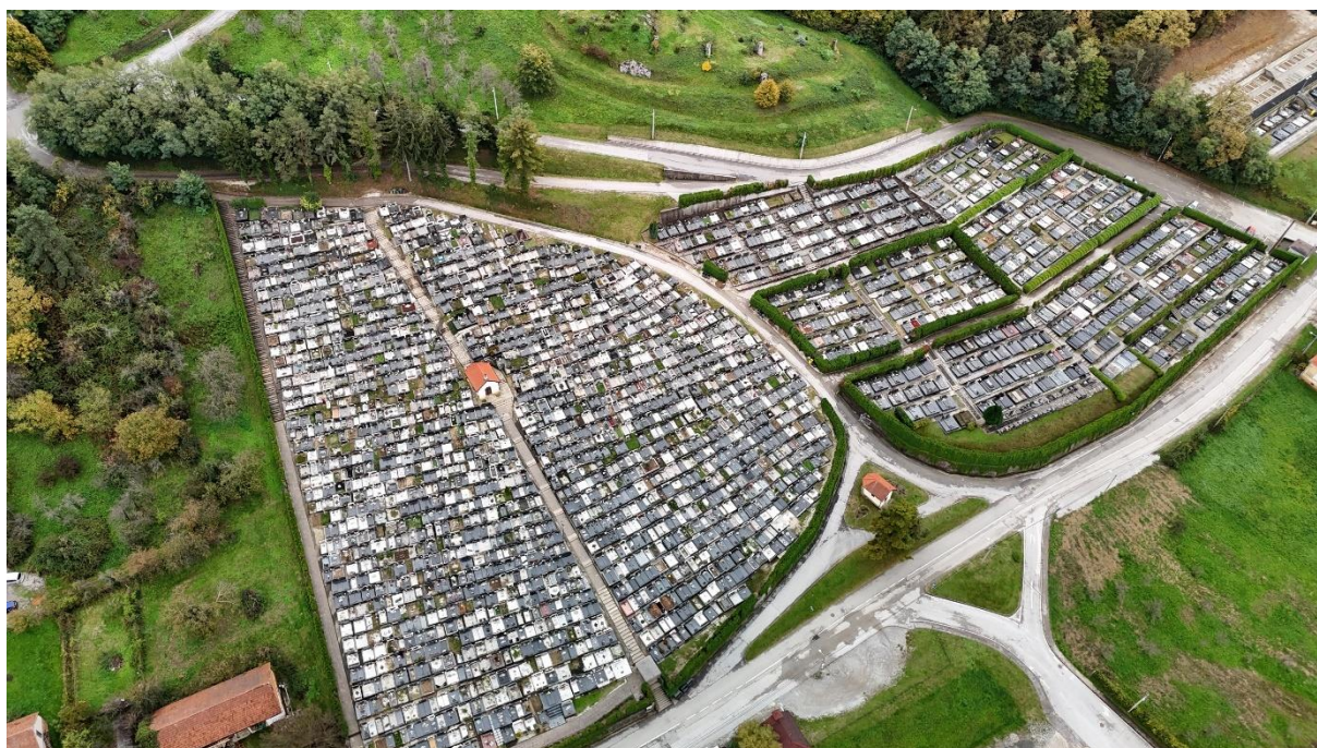
Slika 42. Prikaz krajobrazno uređenog groblja Poljanica Bistranska iz zraka u naselju Poljanica Bistranska. Izvor: Level Project d.o.o.
